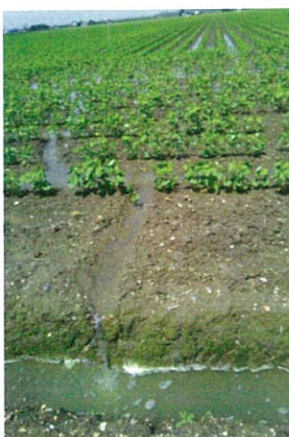
写真1 額縁明きよに停滞水を速やかに排水
